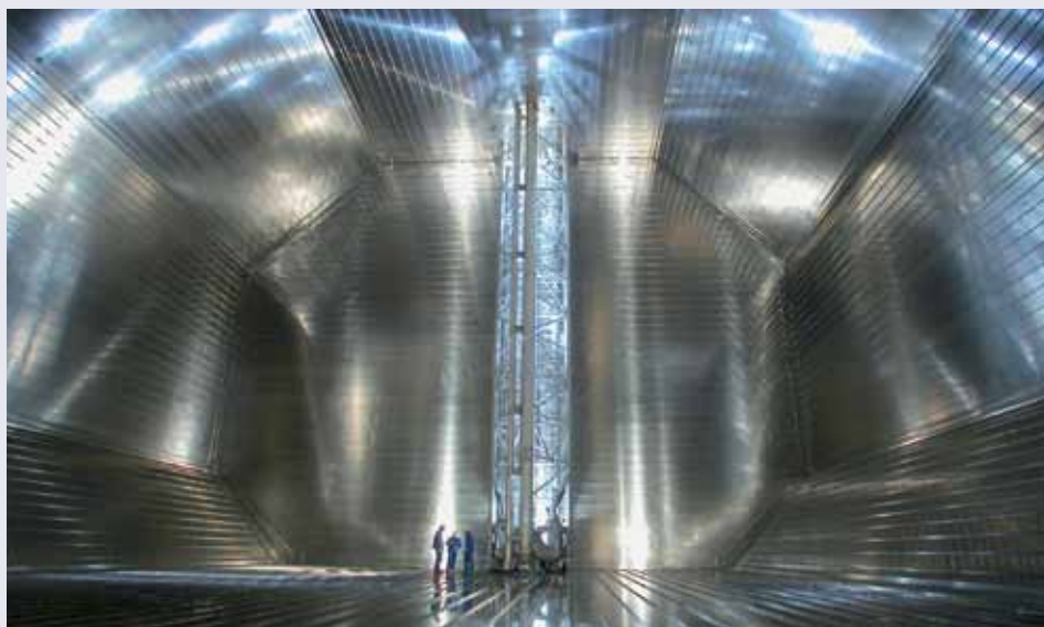
Crédit photo : © GTT - Cuve de méthanier réalisée en Invar®, un des produits-phares du site d'Imphy.
